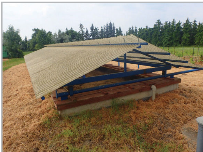
Fot. 8. Stanowisko biodegradacji pozostałości pestycydów przy BioBed (fot. P. Beres)
